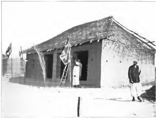
Hausbau in Tabora.
